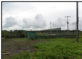
FOTOGRAFÍA 2- ÁREA DESTINADA A LA PLANTA DE TRATAMIENTO QUE YA SE ENCUENTRA EN FUNCIONAMIENTO
