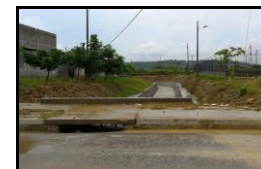
FOTOGRAFÍA 1 COLECTORES PLUVIALES EN ÉPOCA DE INVIERNO DENTRO DE PARQUIAMERICA
